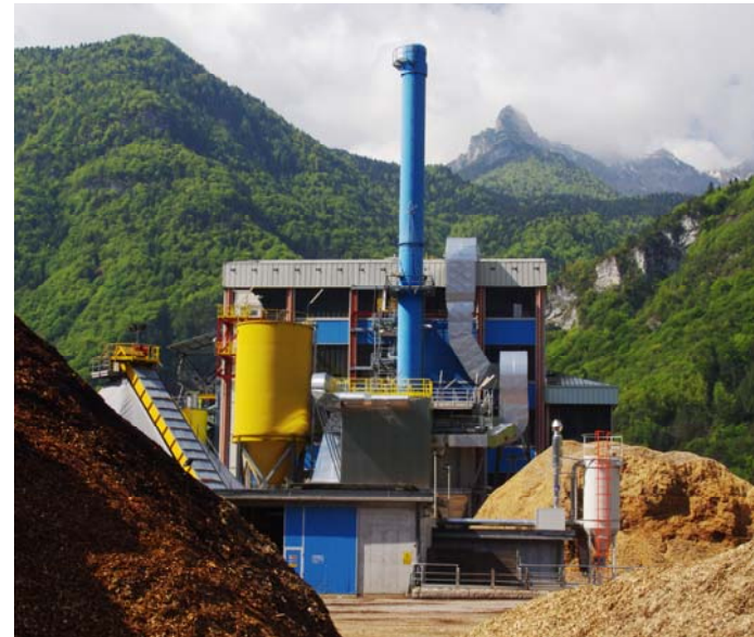
Power plant SICET, Ospitale di Catoro
