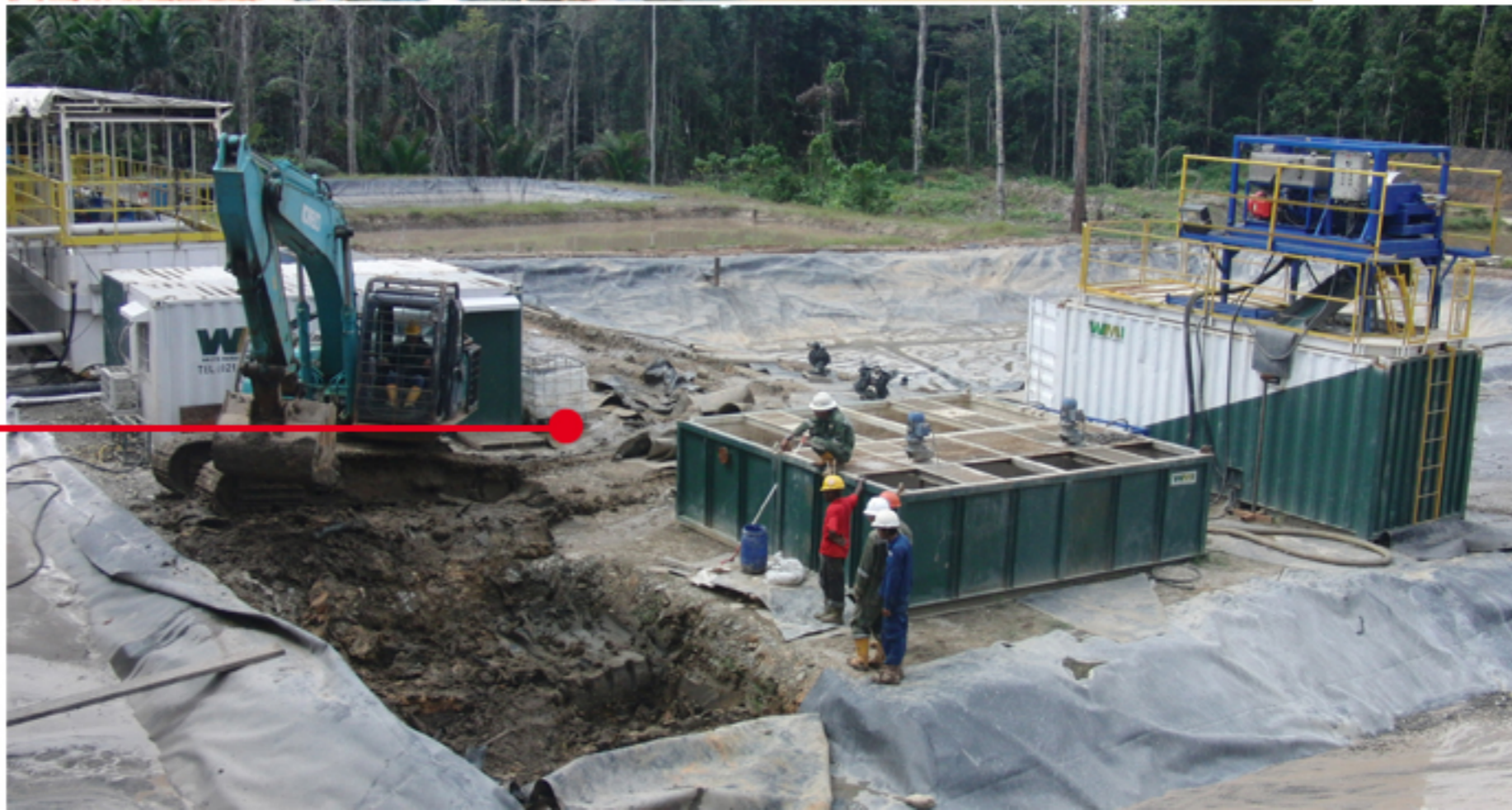
ПРОЦЕС НА ИНСТАЛАЦИЯ НА МИНИ ПРЕЧИСТВАТЕЛНА СТАНЦИЯ
